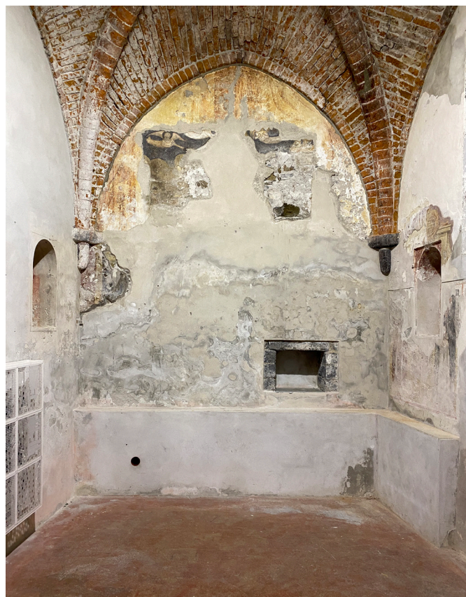
Foto dell'abside e della volta in mattoni
