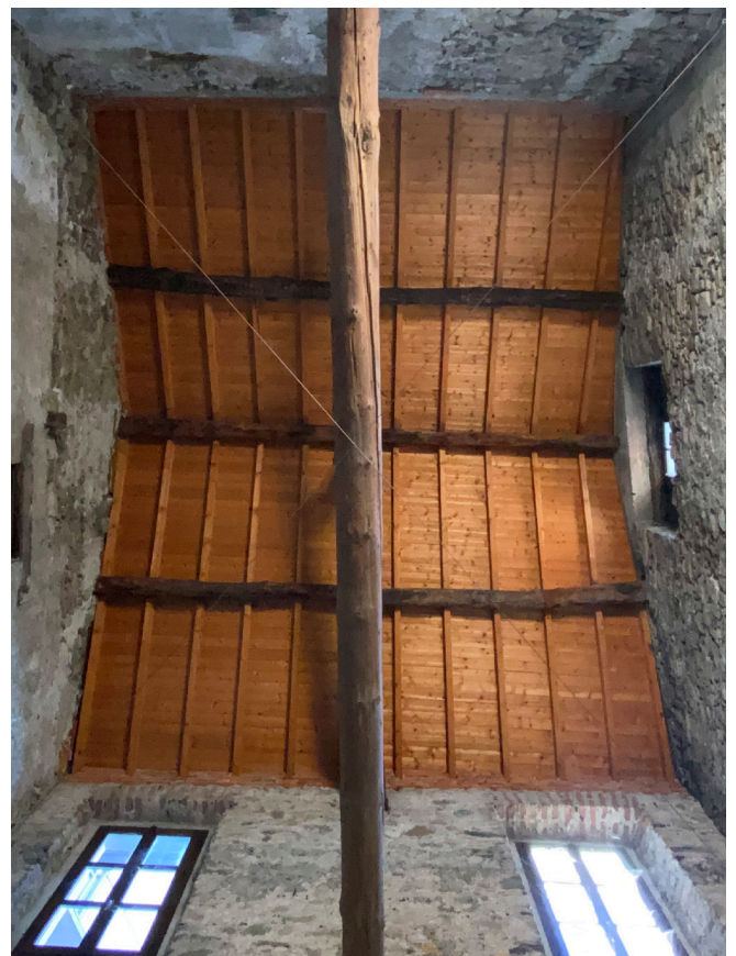
Foto del sistema di travi del tetto
