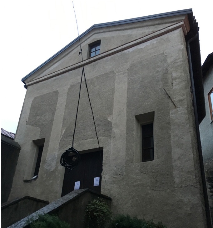
Foto della facciata ovest
