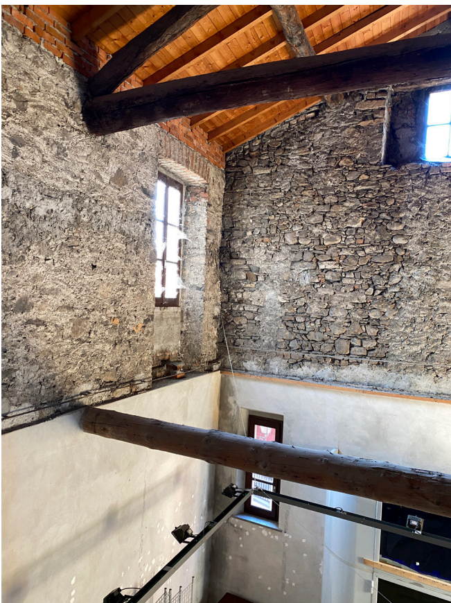
Foto dall'apertura esistente verso la parete d'ingresso
