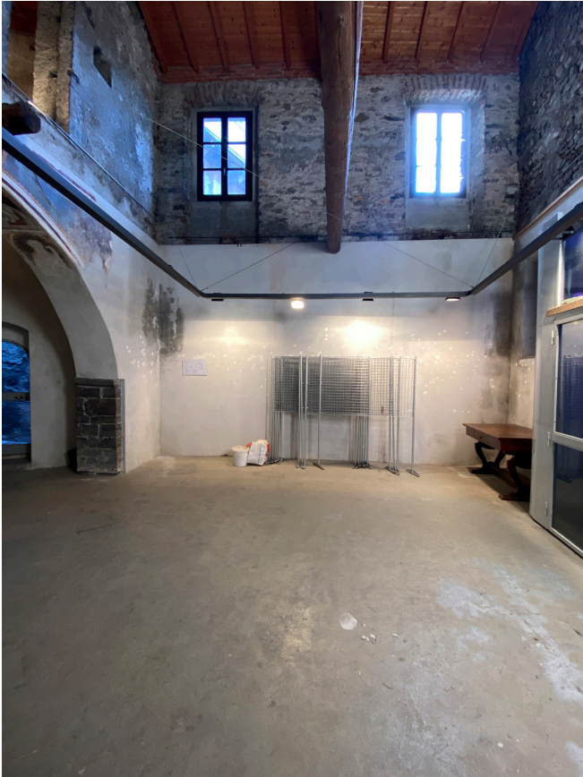
Foto della parete sud della prima campata
