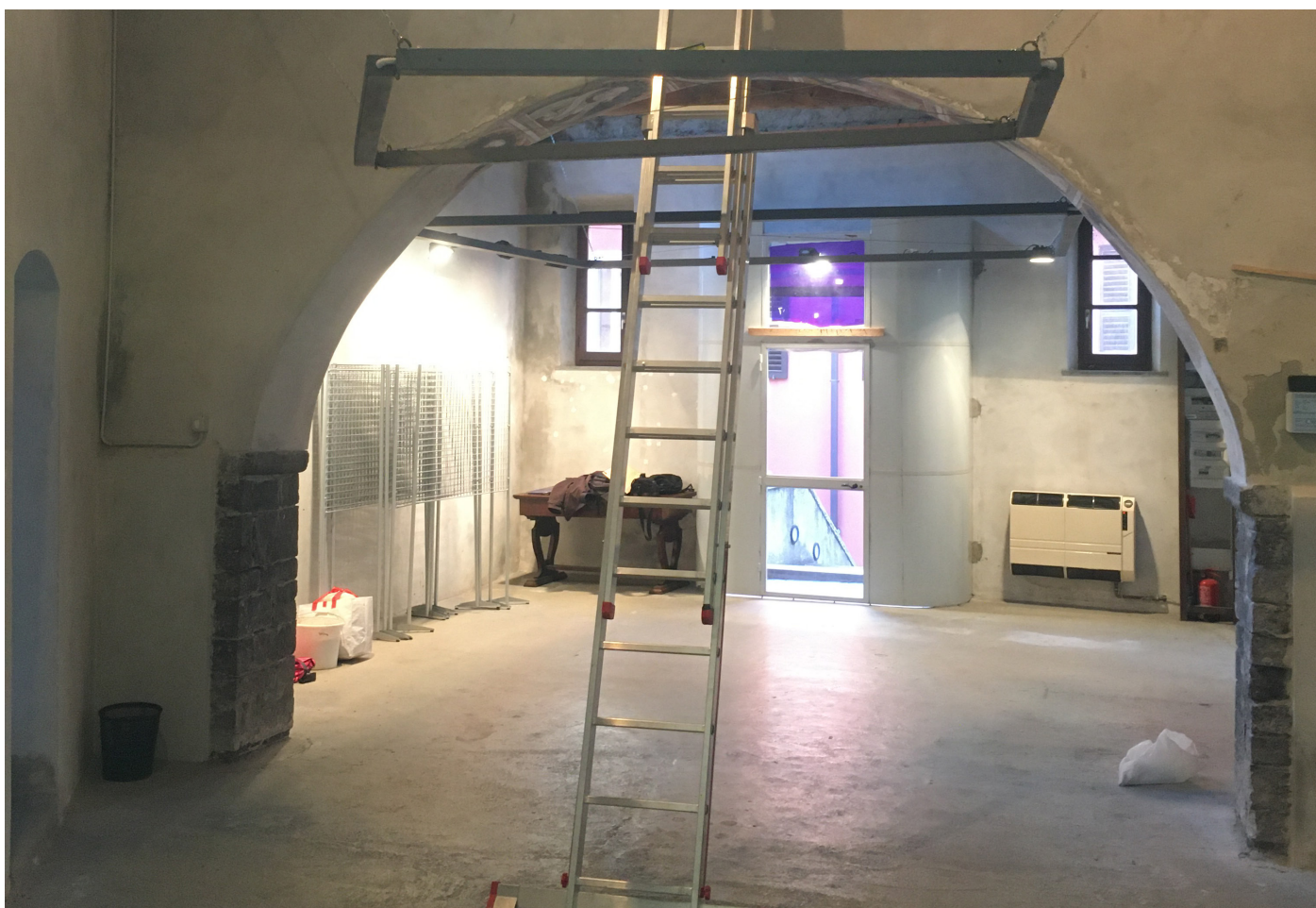
Foto dalla seconda campata verso l'ingresso principale
