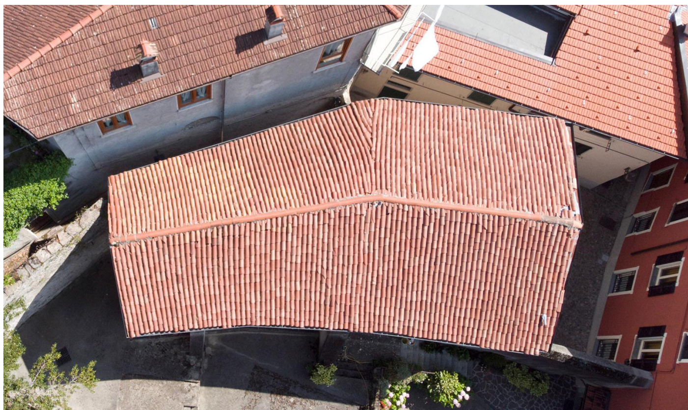
Foto dal drone della copertura
