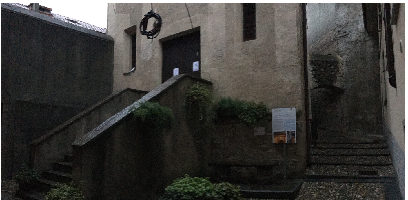
Foto dell'ingresso principale sulla facciata ovest
